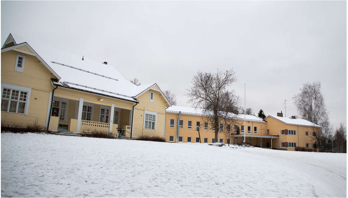
Luopioisten kirkonkylän koulu. Vasemmalla kansakoulu 1900-luvun alusta, oikealla vuonna 1954 rakennettu koulurakennus.
