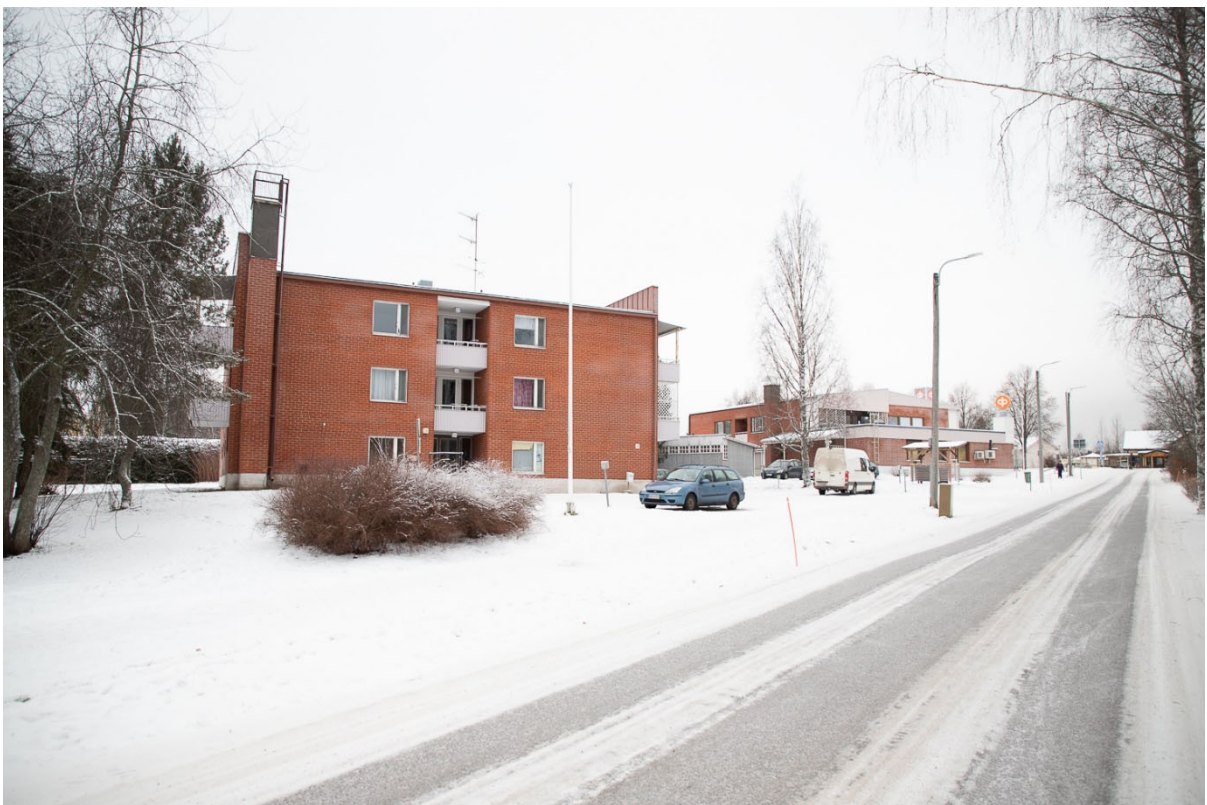
Rajalantiellä suunnittelualueen naapurina sijaitseva kerrostalo.
